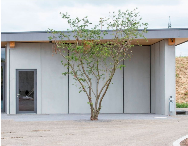
„SchieferErlebnis“ Dormettingen: großformatige hinterlüftete Vorhangfassade mit solidian-Bewehrung, Quelle: solidian
