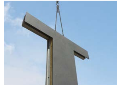
3-schichtiges Textilbeton-Fassadelement
