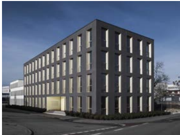
Eastsite VIII: Sandwichwand mit solidian-Bewehrung
