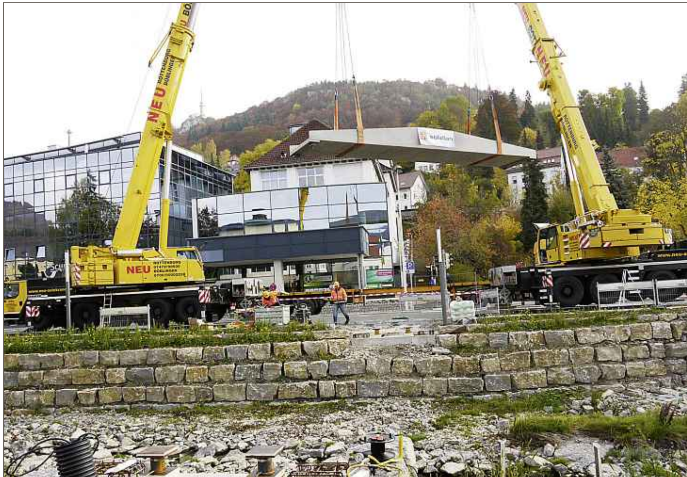
Sie ist so leicht - nur 14 Tonnen wiegt sie -, und doch mussten zwei Kräne die neue Textilbetonbrücke an ihren Standort heben.
